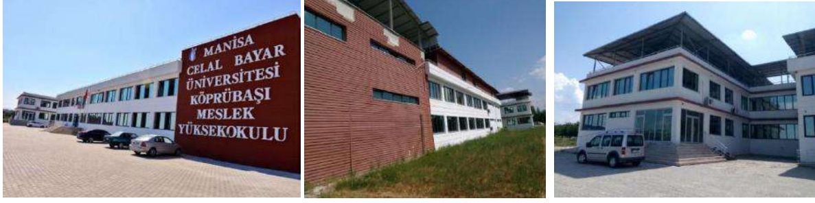
Şekil 1. Köprübaşı Meslek Yüksekokulu binasının cephe görüntüleri
