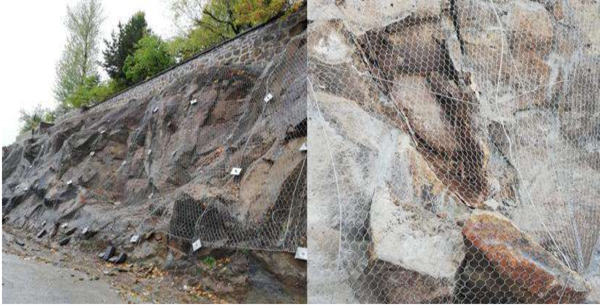
Şekil 8. Yüzeğe hasır serilerek çelik halatlarla birleştirme yöntemi
