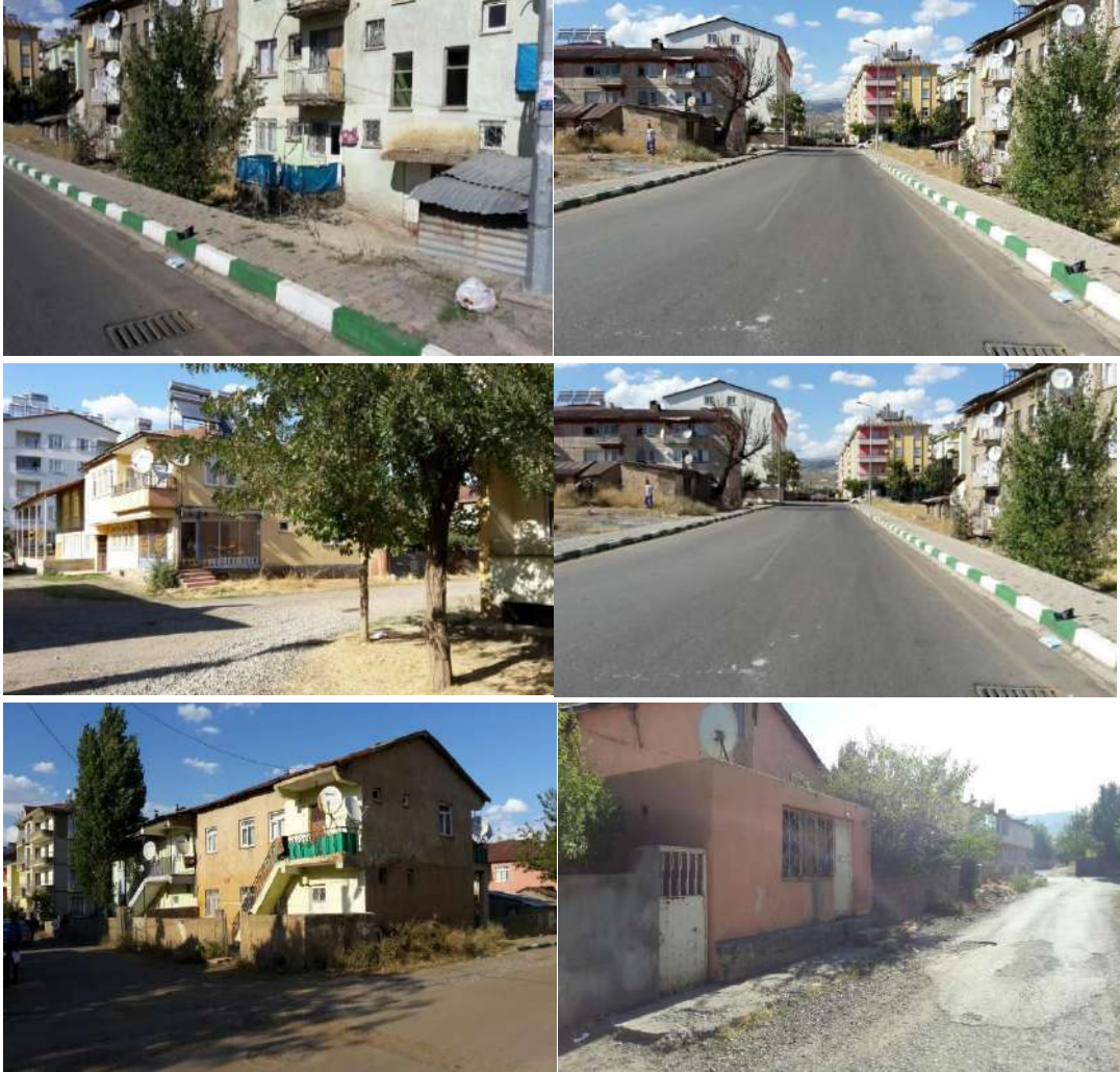
Şekil 1: Kültür Mahallesi Kentsel Dönüşüm Saha Çalışmaları
