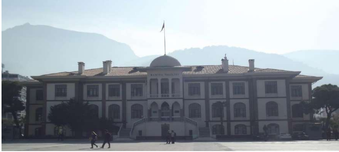
Şekil 11. Hükümet Konağı Cumhuriyet Meydanından Görünüş (Kuzey Cephesi)
