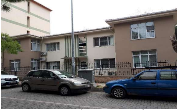
Şekil 7. Orman İşletme Müdürlüğü Ön Cephe
