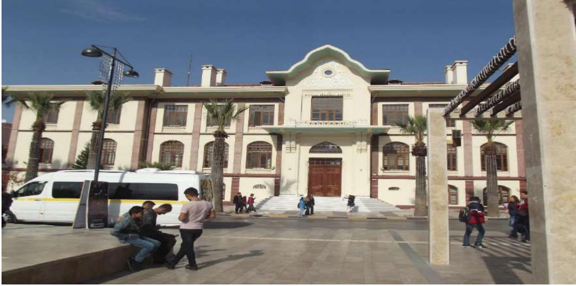
Şekil 12. Hükümet Konağı Emekliler Parkından Görünüş (Güney Cephesi)
